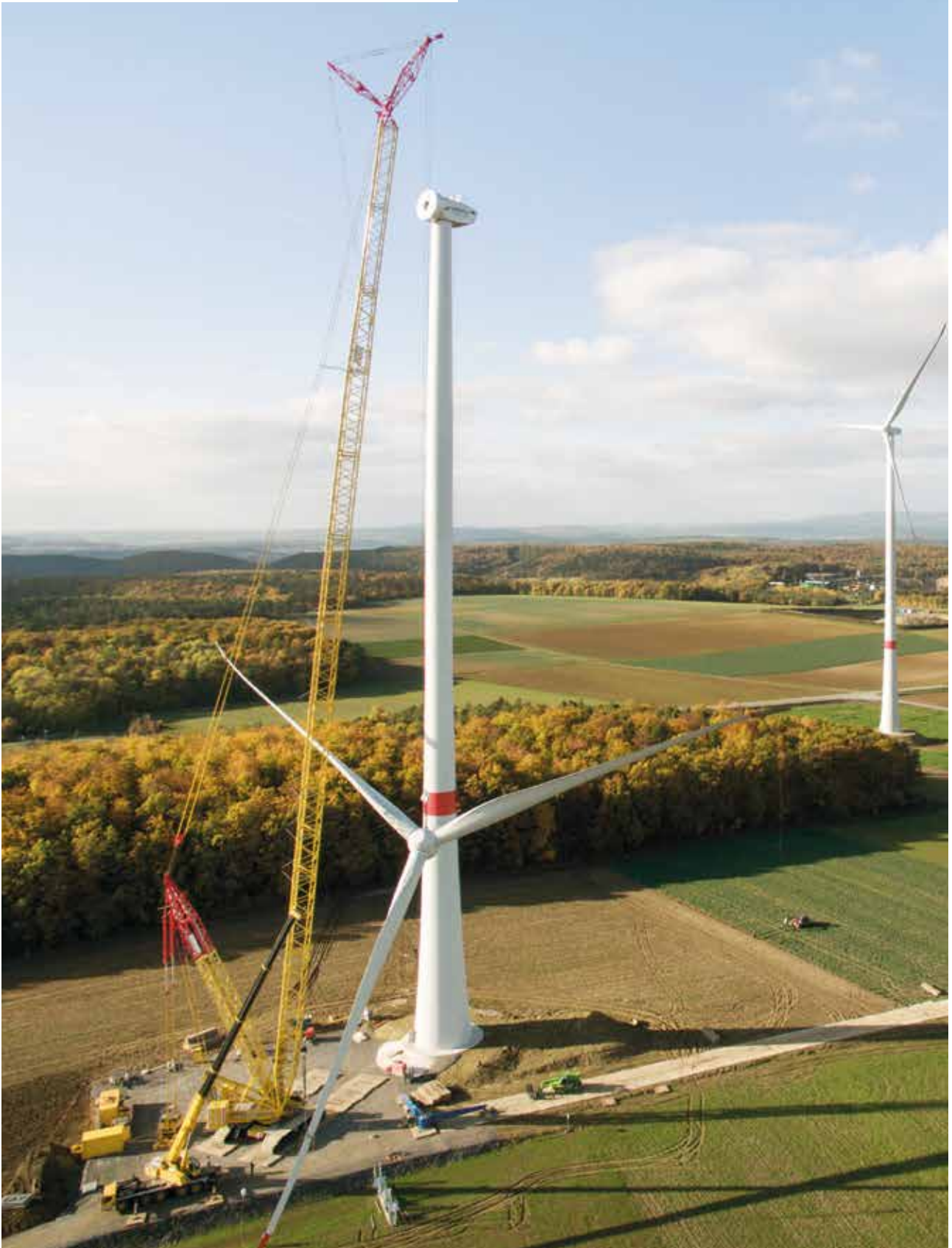
Bau des NATURSTROM-Bürger-Windparks Ramsthal
