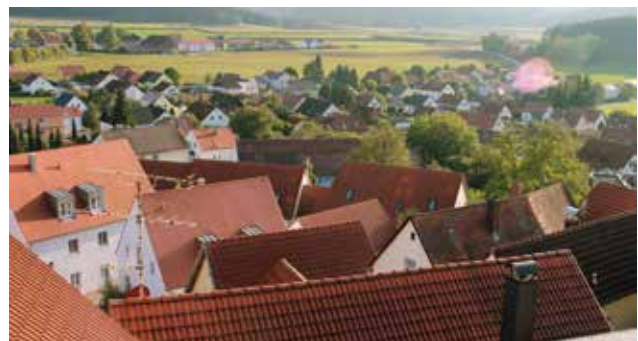
Lupburg: Erstes Nahwärmenetz Deutschlands mit einer Kombination aus Holzvergaser-BHKW mit Power-to-Heat-Anlage.
