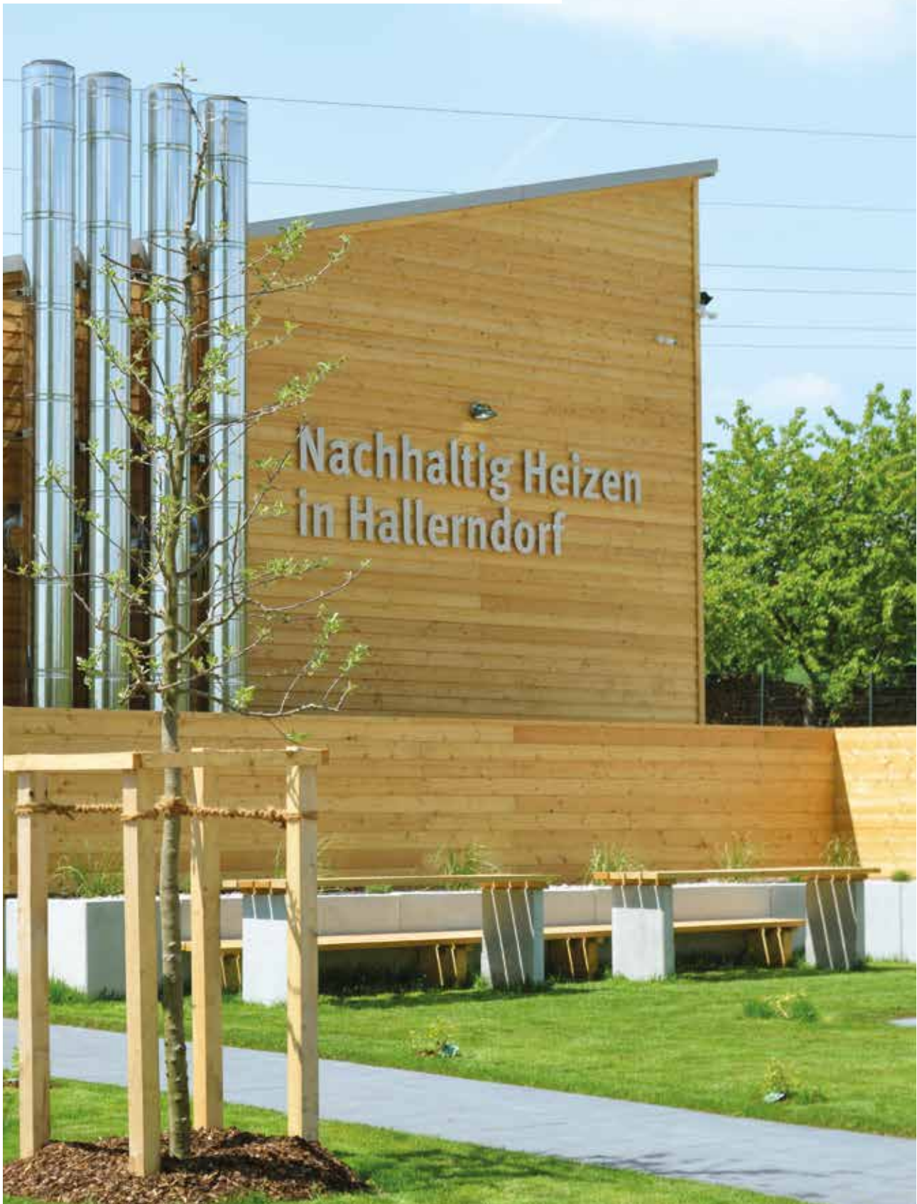
NATURSTROM-Nahwärmenetz Hallerndorf: größte solarthermische Freiflächenanlage Bayerns in Verbindung mit einem Nahwärmenetz
