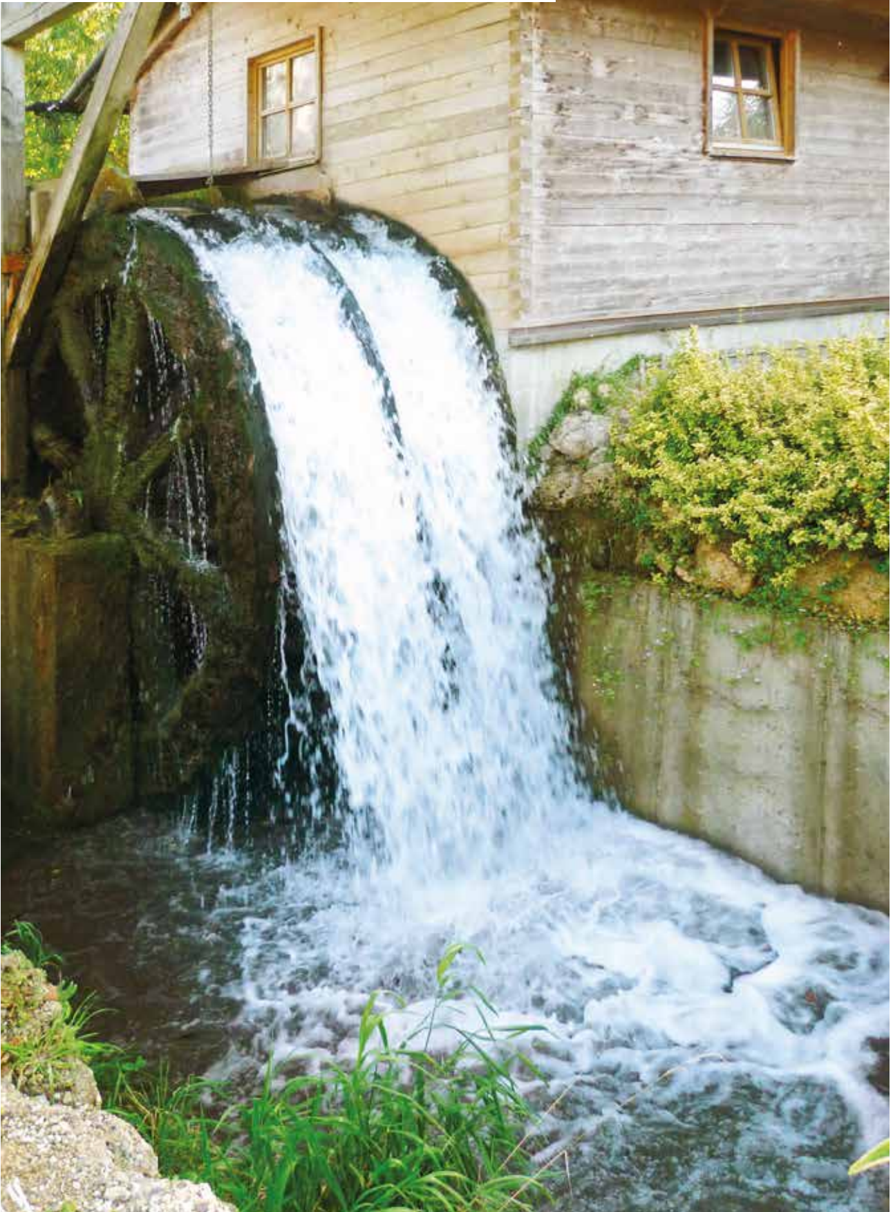
Von NATURSTROM gefördertes Wasserkraftwerk in Flossing
