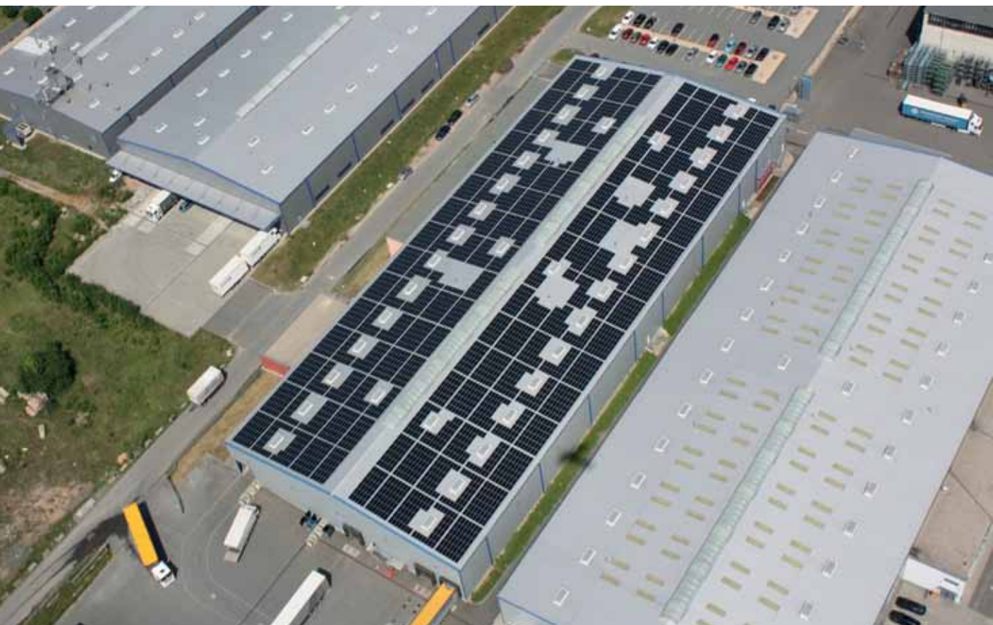
Fotovoltaikanlagen auf dem Dach einer Industriehalle im Industriepark metaWERK Zwickau. Sie verfügen über eine Nennleistung von zusammen 403 kWp und liefern pro Jahr voraussichtlich rund 380.000 kWh Ökostrom.
