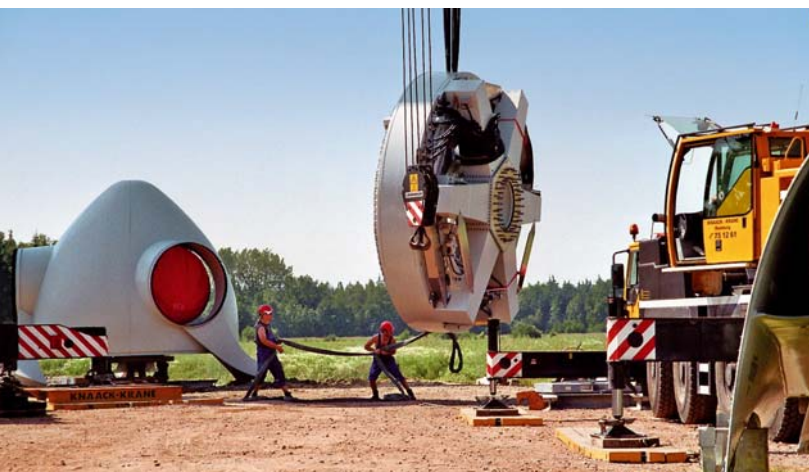
Montage der Windkraftanlagen Hüll
