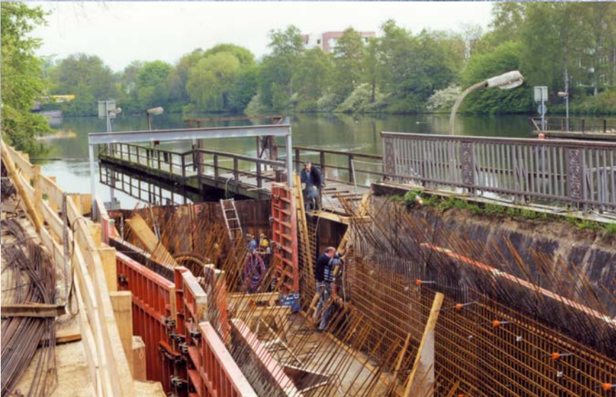
Bau des unterirdischen Maschinenhauses
